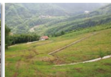
和雅村石壁頭崩塌災害復建工程
