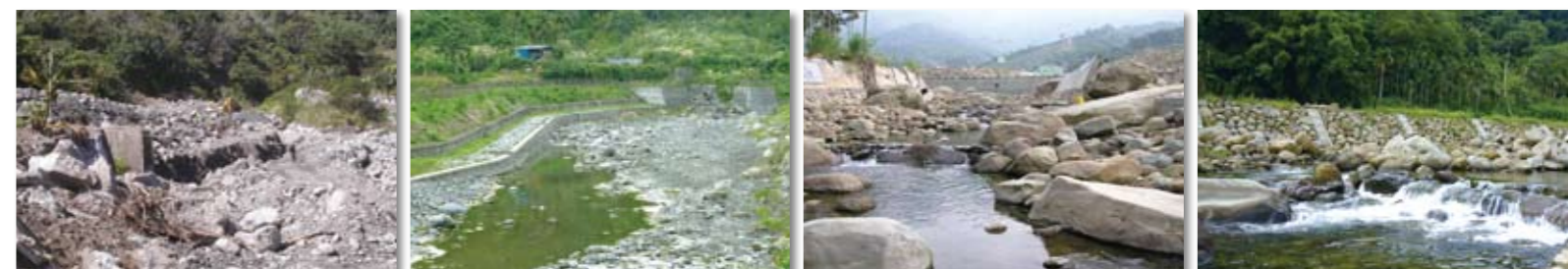
加路蘭溪防砂工程-前、後
