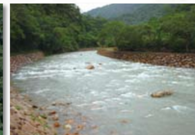
丁子蘭內橋下游災害防治工程
