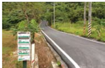
99虎頭山農路設施改善工程-s1
