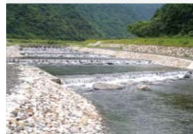
大礁溪上游坡地保育二期工程
