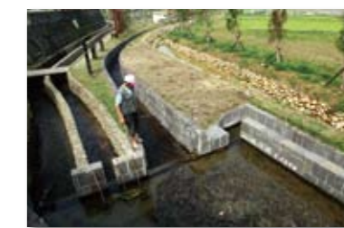
南埔圳維護及周邊親水空間營造工程
