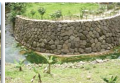
雙溪九份坑野溪災害整治工程
