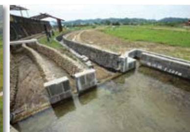
南埔圳維護及周邊親水空間營造工程
