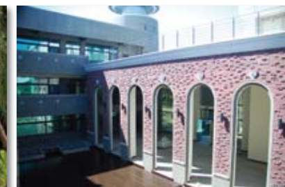
東區土石流防災應變暨品管設施等建築工程
