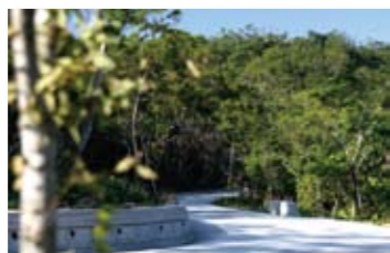
水璉牛山農路設施改善工程
