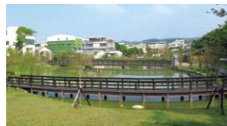
98年度優良農建工程-盧家古厝周邊環境景觀及社區巷道改善工程-彰化縣大村鄉和平社區
