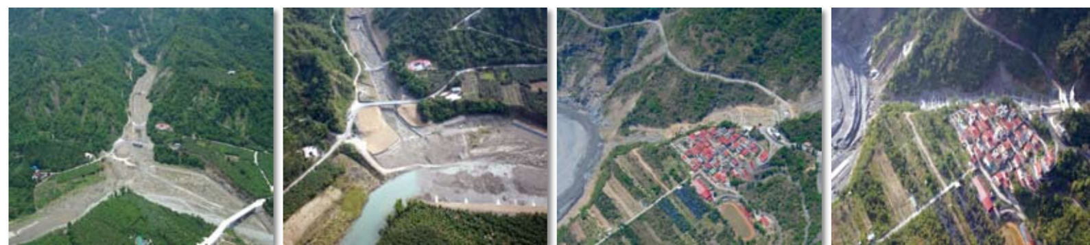
亞美坑災害整治前、後
