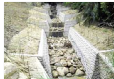
大埔鄉西興村第八莊野溪整治工程
