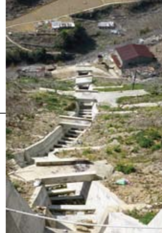
和平鄉環山部落排水治理
