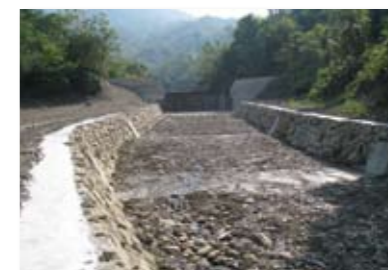
南化鄉關山村草林坑橋土砂防治工程
