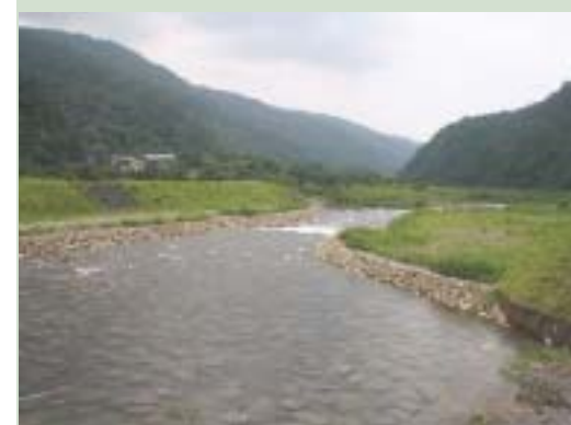
▲宜蘭縣員山鄉大礁溪上游護岸三期工程-1
