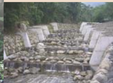
▲嘉義縣中埔鄉石湳村土石流特定水土保持區保育治理工程
