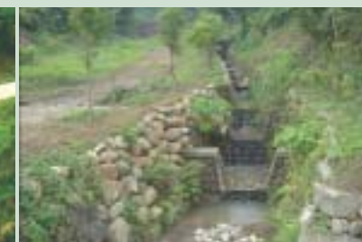
▲南投縣中寮鄉坡地安全排水
