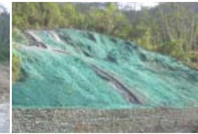
▲宜蘭縣三星鄉 下湖崩場裸坡地植生復育處理——施工中
