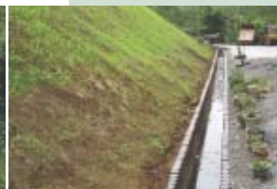
▲花蓮縣富里鄉邊坡穩定
