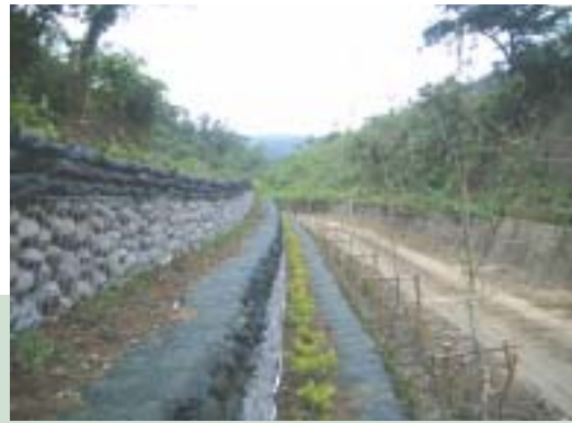
▲花蓮縣壽豐鄉北坑溪裸露地穩定植生處理
