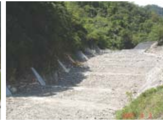
▲台東縣海端鄉紅石溪三期治山防洪工程
