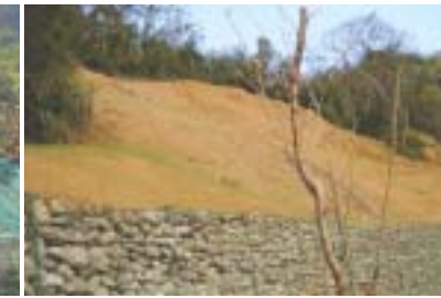
▲宜蘭縣三星鄉 下湖崩場裸坡地植生復育處理——施工後
