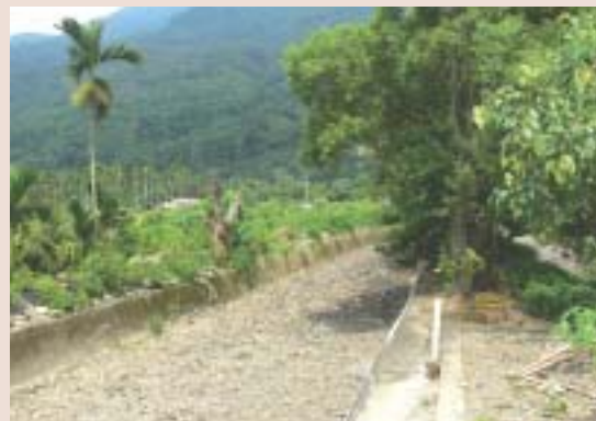
▲溝渠內材料堆積情況及材料粒徑分佈大小-1
