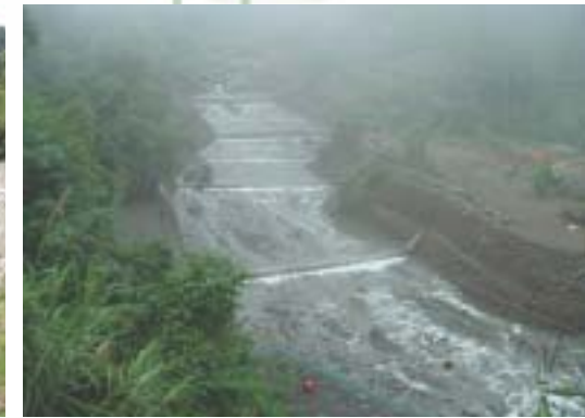
▲嘉義縣竹崎鄉茄苳橋下游野溪治山防洪工程
