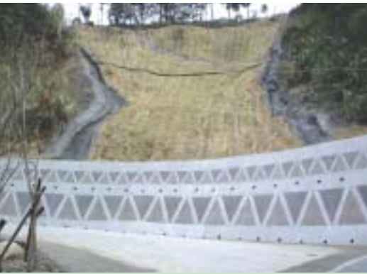
▲南投縣仁愛鄉平靜部落上方崩塌地理—施工後
