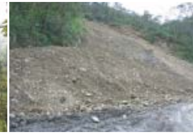
▲宜蘭縣三星鄉 下湖崩場裸坡地植生復育處理——施工前
