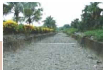
▲溝渠內材料堆積情況及材料粒徑分佈大小-2
