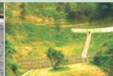
▲新竹縣峨眉鄉坡面穩定處理
