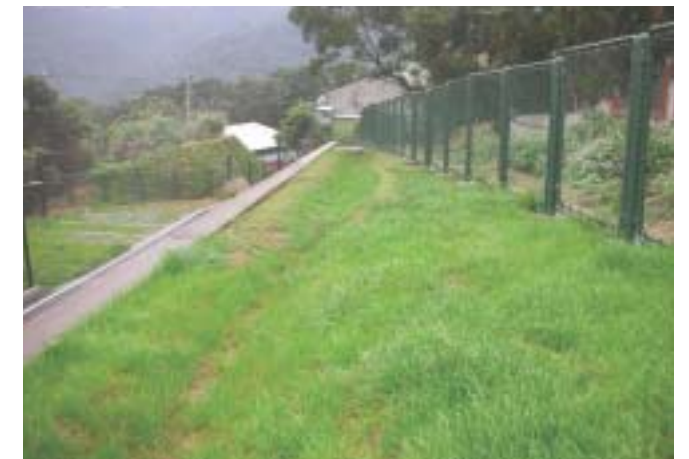
▲高鐵局工程之水土保持計畫監督管理情形
