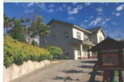
▲南投魚池大雁村農村住宅改善美化
