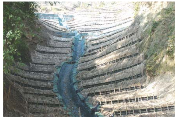
▲苗栗縣大湖鄉南湖村十分嶼段崩塌地處理工程
