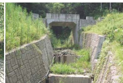
▲花蓮溪-加里洞蝕溝控制工程
