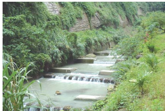
▲嘉義縣中埔鄉青山橋下游整治維護工程
