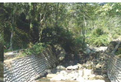
▲高屏溪-比來部落坑溝整治工程
