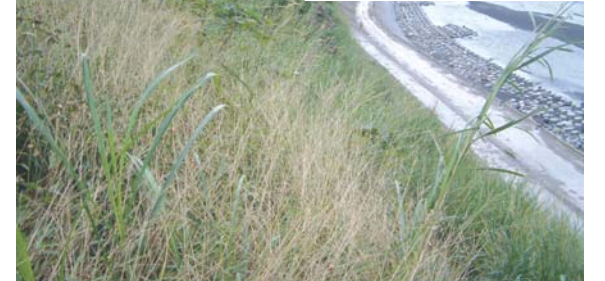
▲台東縣卑南鄉利吉崩場地植生工程施工後
