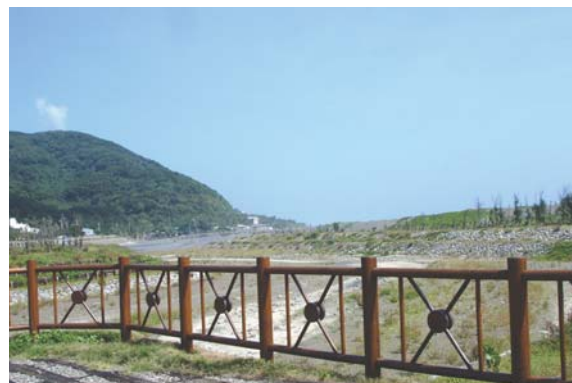
▲旭海溪子集水區工程
