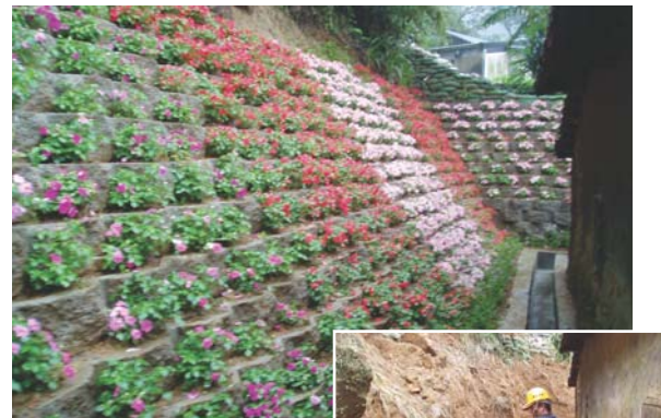
▲台北縣瑞芳鎮九芎橋路126號後方崩場地處理工程施工後
