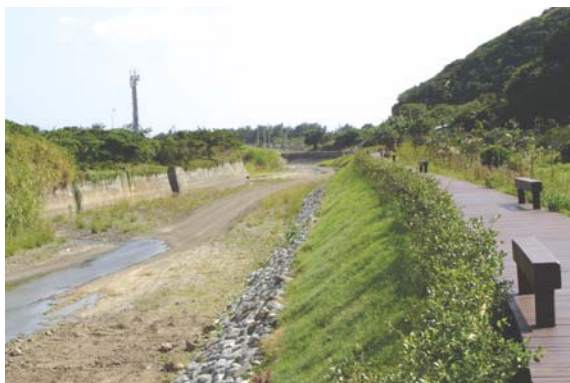
▲旭海溪子集水區工程
