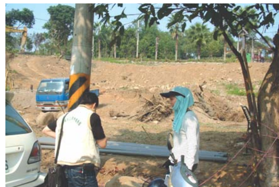
▲雲林縣山坡地違規開挖整地
