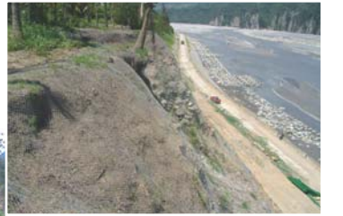
台東縣卑南鄉利吉崩場地植生工程施工前
