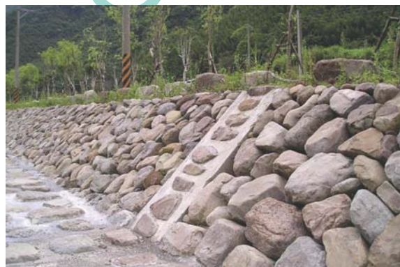
▲利用複式砌石護岸 重視景觀生態
