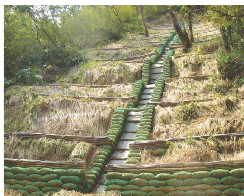
▲台北縣雙溪鄉后番子坑崩塌地處理工程
