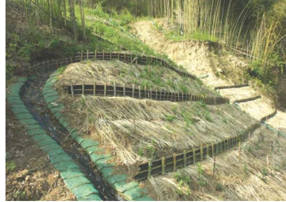
▲苗栗縣大湖鄉南湖村十分嶼段崩塌地處理工程
