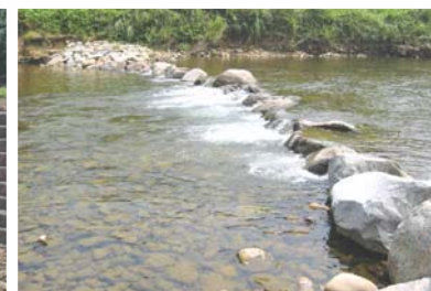
▲台中縣抽藤坑溪整治工程
