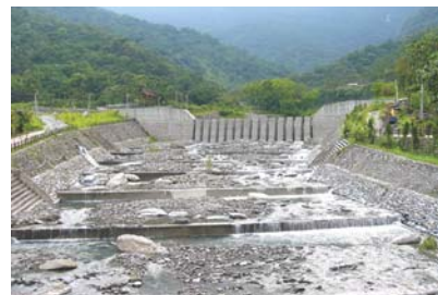
▲花蓮縣鳳義水源池整治工程
