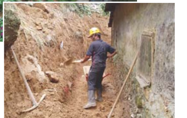
台北縣瑞芳鎮九芎橋路126號後方崩場地處理工程施工前
