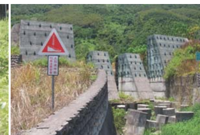
▲花蓮溪-見晴防砂工程
