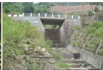
▲大甲溪-2 號野溪中游段橋樑整治工程
