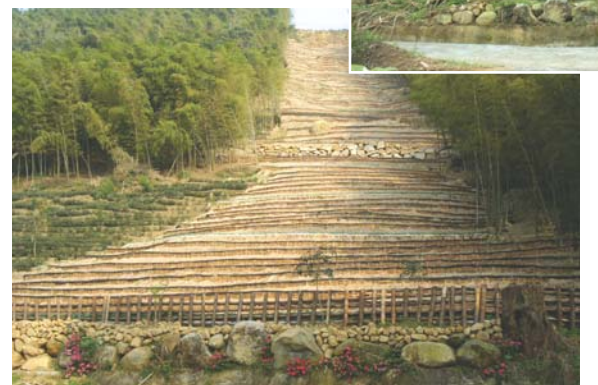
▲南投縣鹿谷鄉鳳凰村八通關古道崩塌地處理工程施工後
