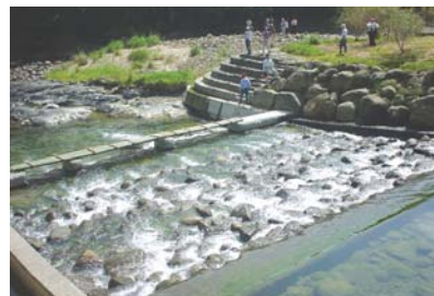
▲苗栗縣新店溪整治工程
