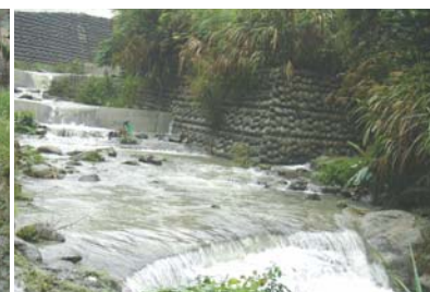
▲高屏溪-大寮野溪整治二期工程
