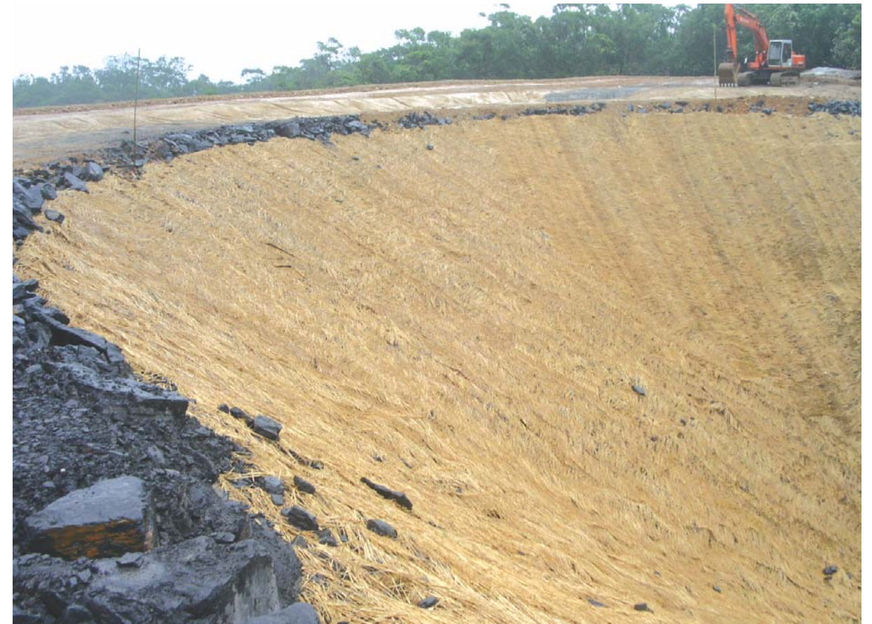
▲台中市山坡地開發案邊坡保護
