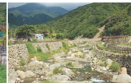
▲東港溪-苦苓溪整治二期工程
