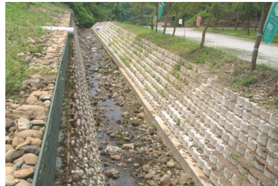
▲台南縣南化鄉坡地安全排水
