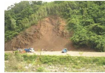
◀台東縣海端鄉加拿崩場地植生工程施工前
