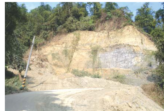
▲台南縣山坡地違規開挖整地
