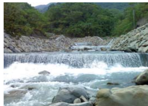
丹路橋上游野溪整治三期工程
