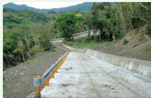
台東縣東河鄉農路改善(改善後)
