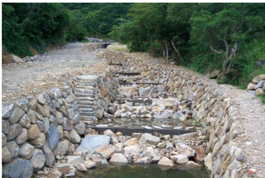
達天員潭溪整治工程
