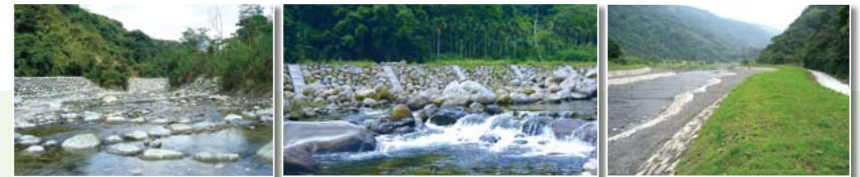
白鮑溪土石災害防治二期工程
