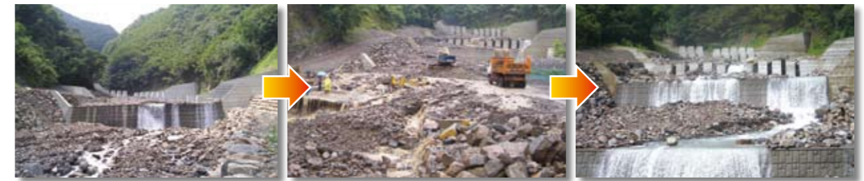
蘇樂溪保育治理工程-9605(完工後)
