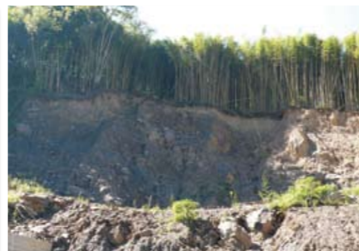
民間參與-延老部落南側災害復建工程施工說明會
