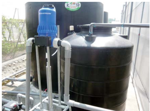
▲ 定比稀釋器屬於簡易型的即時注入式調肥器具
