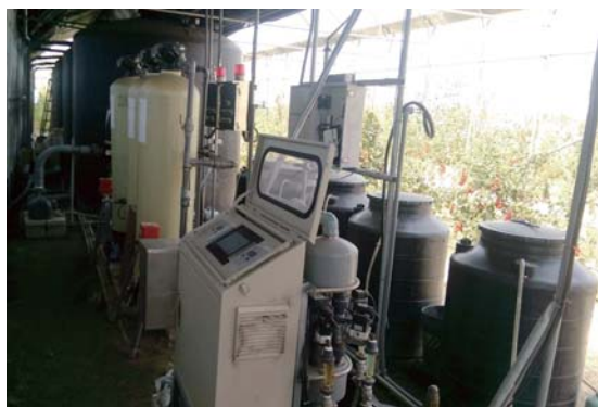
▲ 設施園藝作物應用之管路灌溉施肥系統及地下水質處理設備
