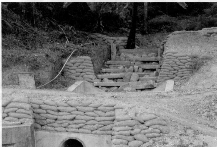
圖一、邊坡基礎整理後堆置土石包的情形
