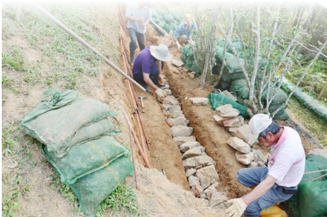
圖二、底層基礎座施作砌石增強排水性。
