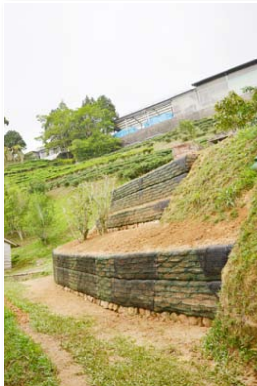
圖四、崩塌坡面經修護完成後並保留原地生長的茶樹
