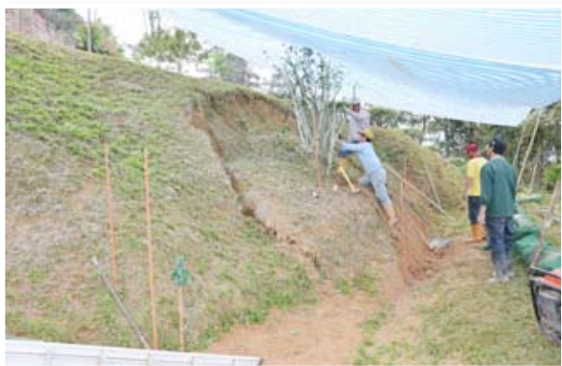
圖一、崩塌邊坡進行修護規劃放樣。
