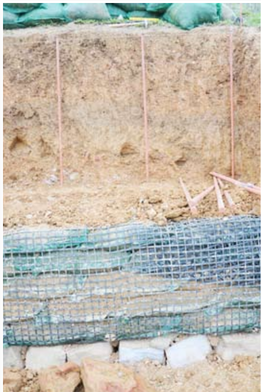
圖三、內坡面植入竹節鋼筋並在基礎座上堆疊施作抗沖蝕網袋
