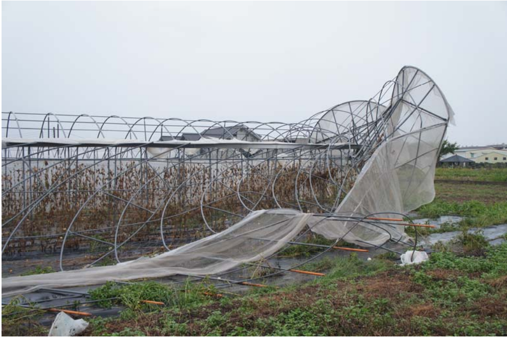
圖 3. 訪視后里農民劉文泳之設施損壞情形
