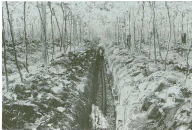
圖 7 葡萄園埋設暗管有利排水
