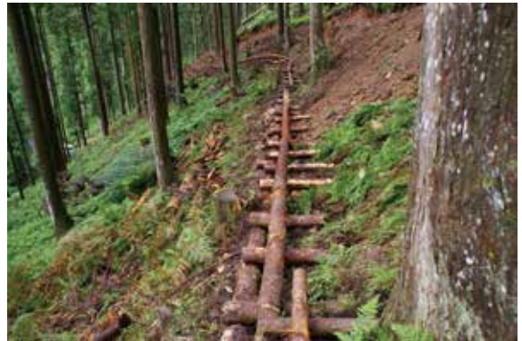
▲作業道下邊坡原木擋土工法
