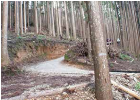
▲作道路迴頭彎施做完成情形
