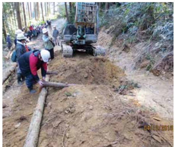
▲作業道實務操作教育訓練現場操作情形
