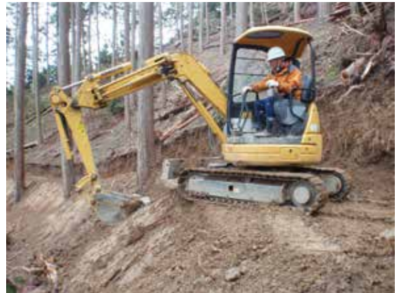
▲作業道施工應以最低限度伐開為原則
