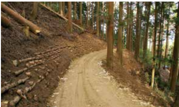
▲作業道上邊坡原木擋土工法
