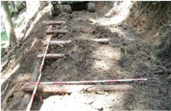
▲作業道路面利用原木加強處理情形
