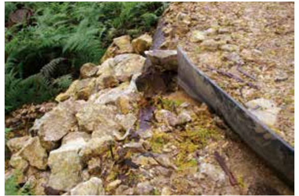
▲作業道橫向排水下邊坡鋪排塊石
