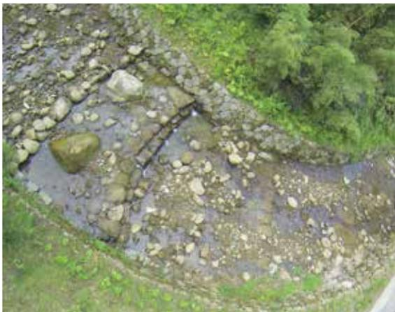
▲照片6 弧形固床工，調控河道流心
