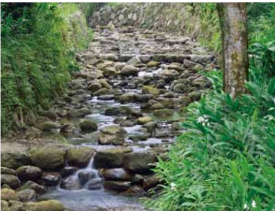
▲照片8 低矮固床工，確保縱向生態廊道，利於生物溯游
