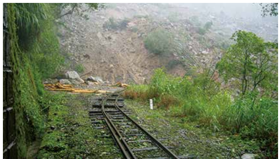
▲圖2 屏遮那段崩塌區
