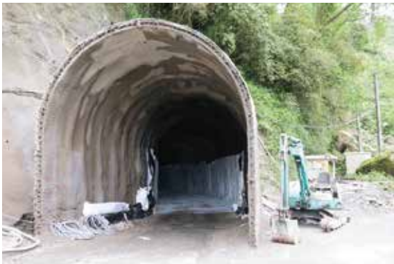
▲圖21 落石防護網及假隧道延伸5m
