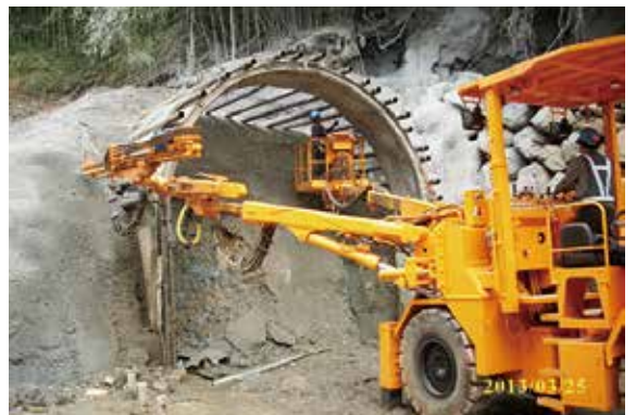
▲圖19 西洞口培厚搭配管幕工法
