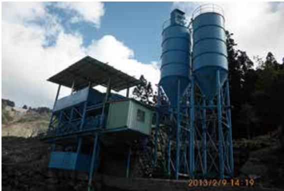
▲圖17 工地拌合廠
