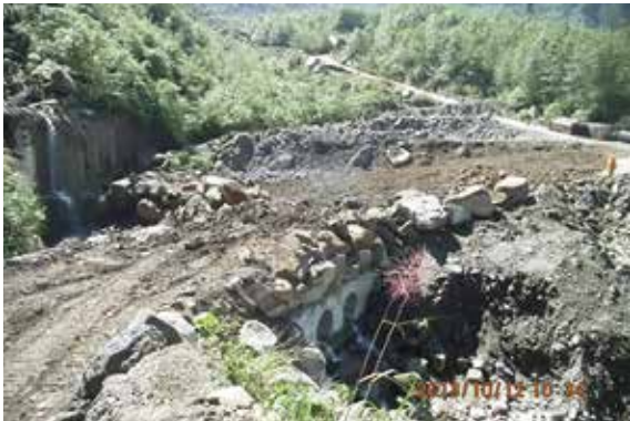
▲圖20 乾砌塊石牆及涵管施工完成照片
