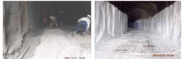
a. A型盲溝鋪築
