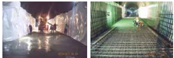
c. 鋪底混凝土
