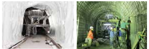
a.全罩式防水層鋪設
