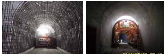
g. 上部防水層及鋼筋
