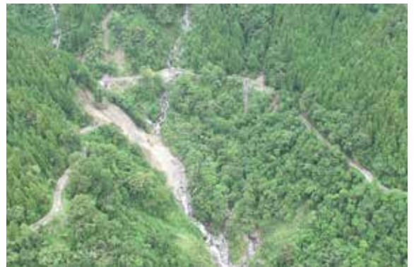
▲大鹿林道6.8K受災情形（直升機空拍）
