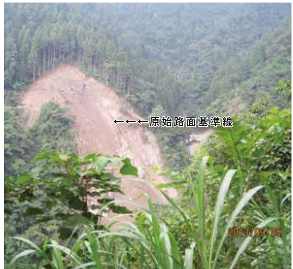
▲大鹿林道6.8K搶通施工高繞削山情形遠眺
