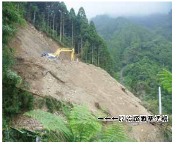
▲大鹿林道6.8K搶通施工高繞削山情形近照
