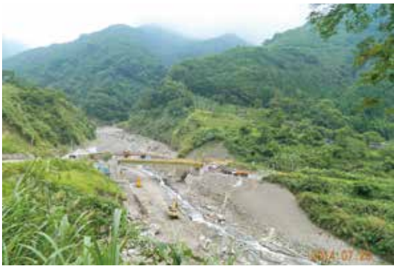
▲大鹿林道1K土場橋新建工程施工照片
