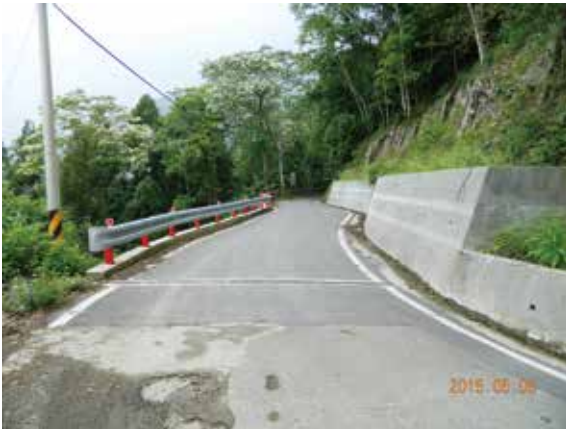
▲大鹿林道3.5K復建完成情形
