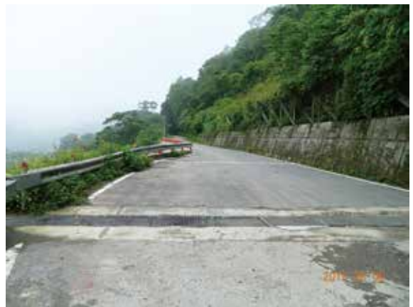
▲大鹿林道3.1K復建完成情形
