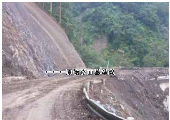
▲大鹿林道6.8K搶通完成情形
