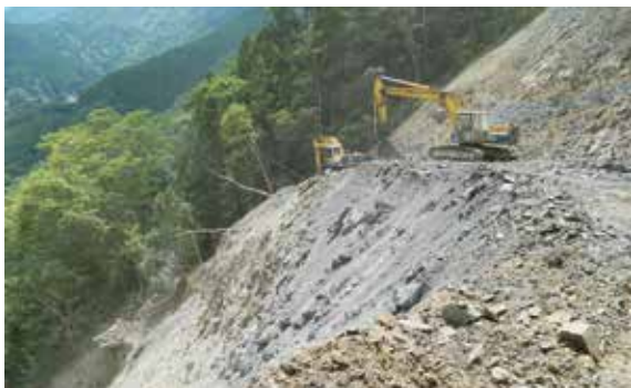
▲大鹿林道5.2K搶通施工及完成情形
