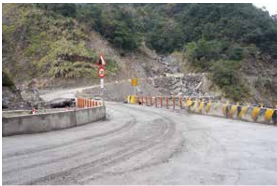
▲大鹿林道8.7K-9K搶通完成情形（橋面版鋼樑已重新安裝）
