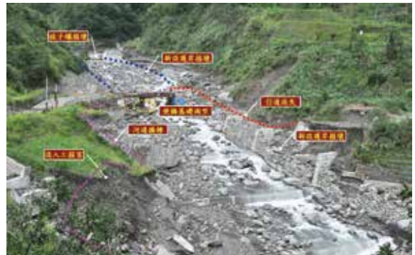
▲ 土場溪土場便橋遭沖毀情形
