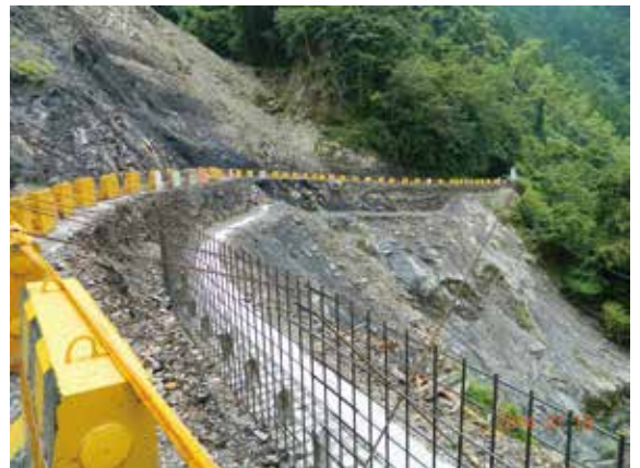
▲大鹿林道10.3K工區施工照片
