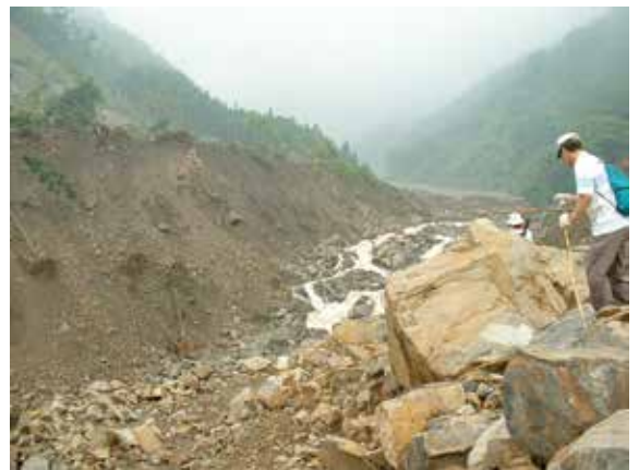
▲大鹿林道1公里處土場溪沖刷情形（93.8.28）
