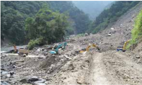
▲大鹿林道8.7K-9K搶通施工情形
