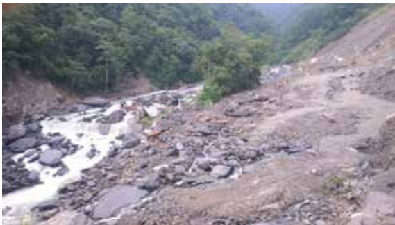
▲大鹿林道9K受災情形，河道嚴重淤積造成溪水紊流
