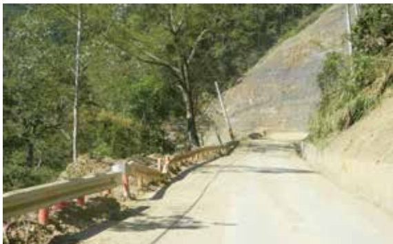
▲大鹿林道5.2K搶通施工及完成情形
