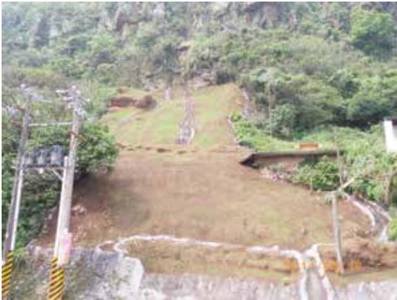
▲掛網噴漿溝及植生積材進行坡面排水及植生完工
