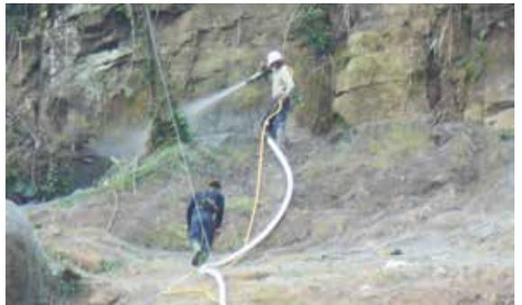
▲ 巨石崩落崩坍面掛網噴漿溝及植生積材進行坡面排水及植生
