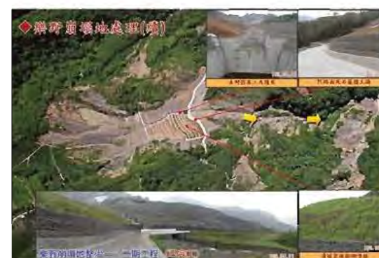
圖16 樂野崩塌地處理成效
