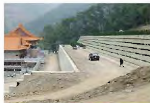
崩塌地基圍填土牆完工情形
