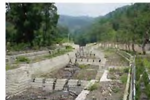
舊潭腳溪整治及周邊環境復生情形
