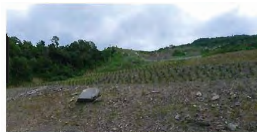
崩塌地坡面復生情形
