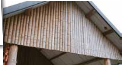
● 為了保護竹涼亭免於蟲蛀，每半年都得噴塗防蛀油加強防護。
