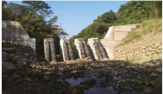
● 圖四、頓阿巴娜野溪上游崩塌地處理工程，納入生態保育考量設計之梳子壩、砌石護岸以及維持自然水域棲地之塊石溪床。
