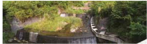
● 圖二、頓阿巴娜野溪整治二期工程，以傳統混凝土構造為主。
