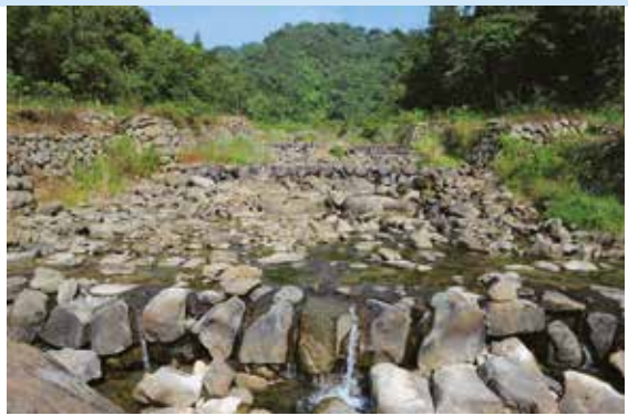
● 圖三、頓阿巴娜野溪整治五期工程，以連續的低矮固床工取代高壩。
