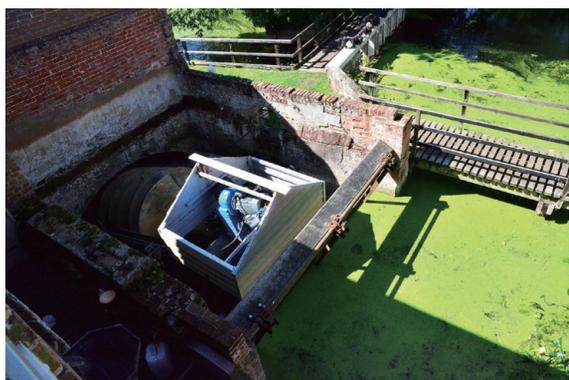
▲圖2、原蒸氣水車運轉處，現改為發電機
