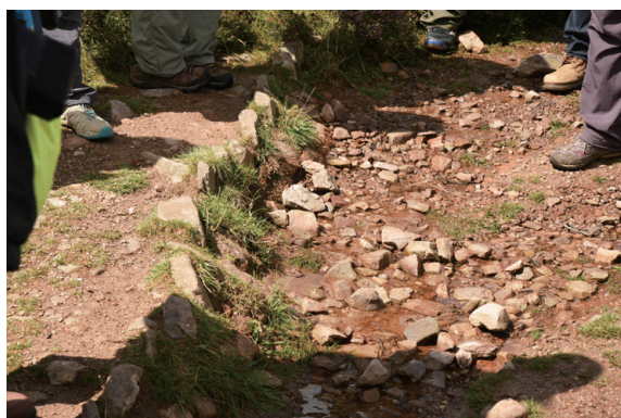
▲圖11、主要步道沿線之簡易排水溝
