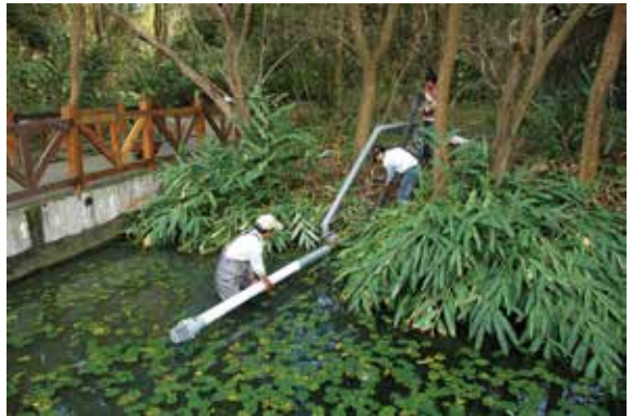
▲圖9、特生中心生態教育園區架設管路建立水循環，營造靜水及流水域供對棲地需求不同之動物進駐。(攝影／曹又仁)
