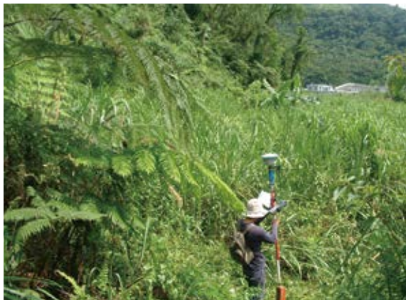
▲ 現場檢訂測量工作
