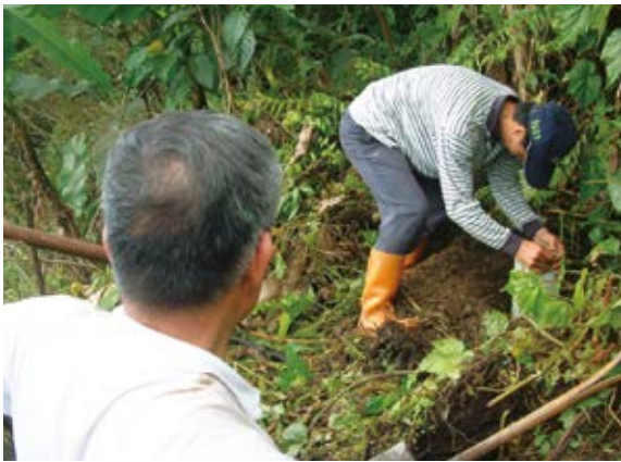
▲ 現場檢訂人員埋測衛星控制點樁
