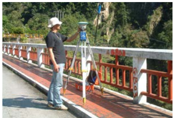
▲衛星定位測量儀（RTK靜態測量之基站）
