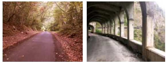
▲ 圖14、第2621號保安林內林道及台14線明隧道
