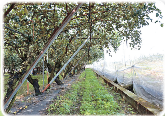
棗園屬加強型水平棚架網室，構造樑採樑柱斜撐方式，搭配深埋3.3尺的地牛接鋼索固定。
