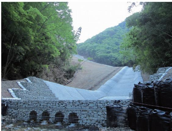
▲圖7、【長殿地區】緊急對策工（臨時排水路工程）
