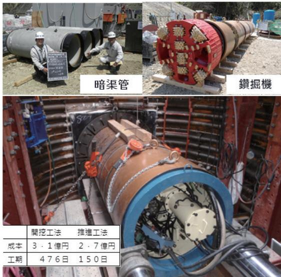
▲圖 11、利用推進工法佈設暗渠排水管
