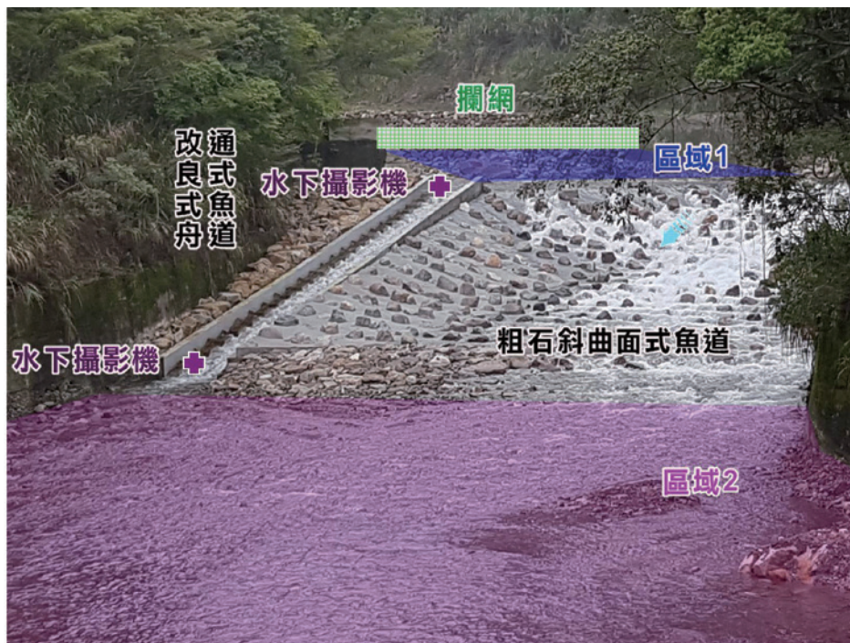
▲圖8、橫流溪魚道溯游魚類調查配置示意圖（照片經加工套色，非原水體顏色。）
