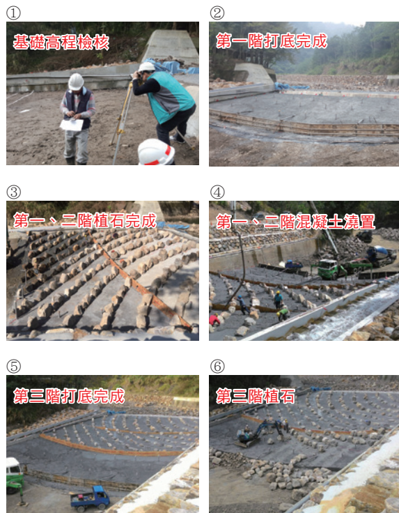
▲圖6、粗石斜曲面魚道施工過程示意圖
