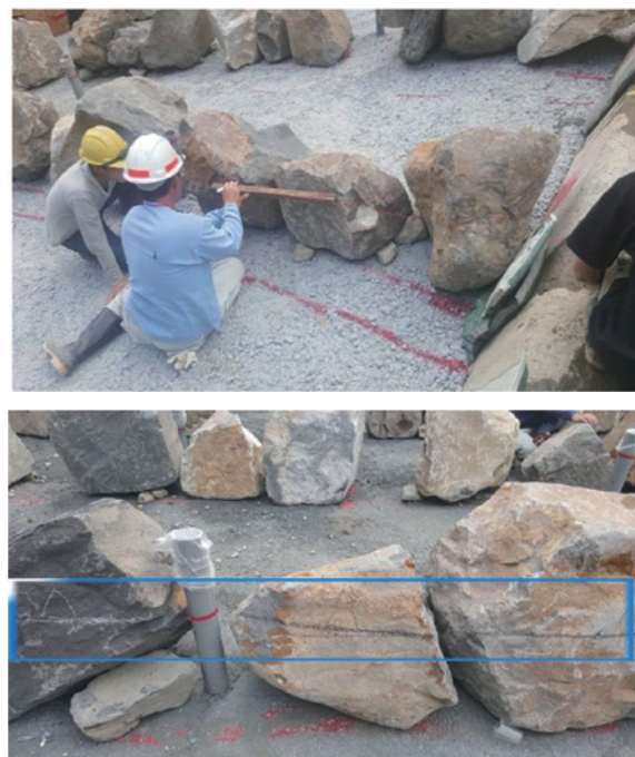
▲圖7、粗石斜曲面魚道澆置放樣示意圖
