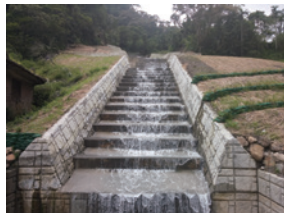
▲新店區平廣路151號旁坑溝整治1期工程
