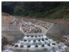
▲新店區平廣路一段273號旁坑溝整治工程
