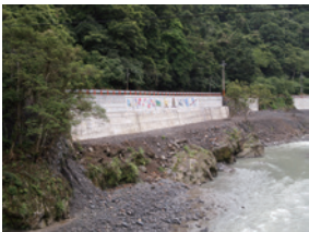
▲內洞森林遊樂區蘇迪勒颱風災後復建工程（第1期）
