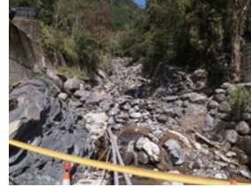
▲樟樹溪支流土石下移造成構造物損壞
