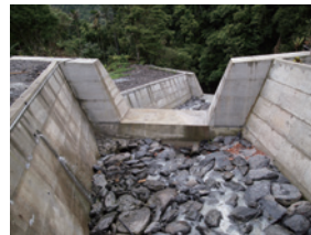
▲烏來事業區21林班樟樹野溪第1期整治工程
