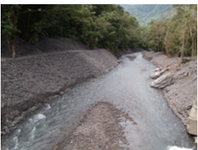
▲烏來區第11林班阿玉溪河道整理1期工程
