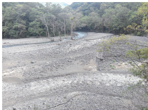
▲桶后林道9.7公里處桶後溪凹岸淘刷嚴重
