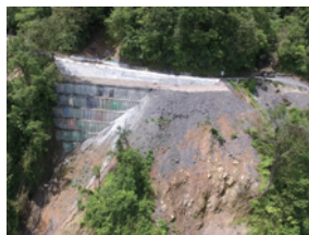
▲桶后林道0~3公里蘇迪勒颱風災害復建工程
