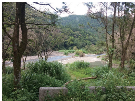
▲桶后林道12.5公里處桶後溪河道淤積嚴重
