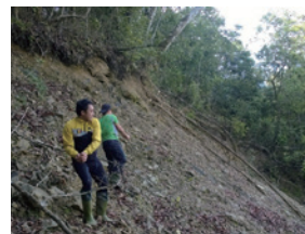
▲東札孔溪崩塌地復育工作
