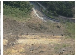
▲104年國1號崩塌地復育工作
