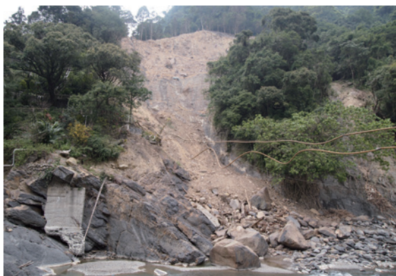
▲烏來2林班妙心寺旁崩塌
