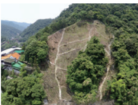
▲烏來區2林班崩塌地處理1期工程
