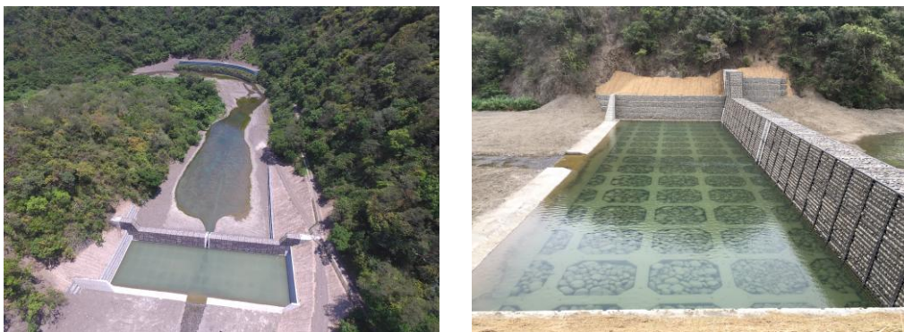
圖 1 里仁溪整治二期鋼製自由框防砂壩
