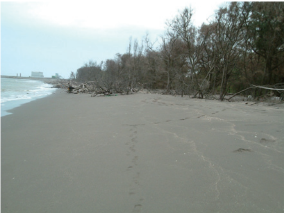
▲照片1、海岸木麻黃防風林遭（突堤效應）海水冲刷淘空等危害
