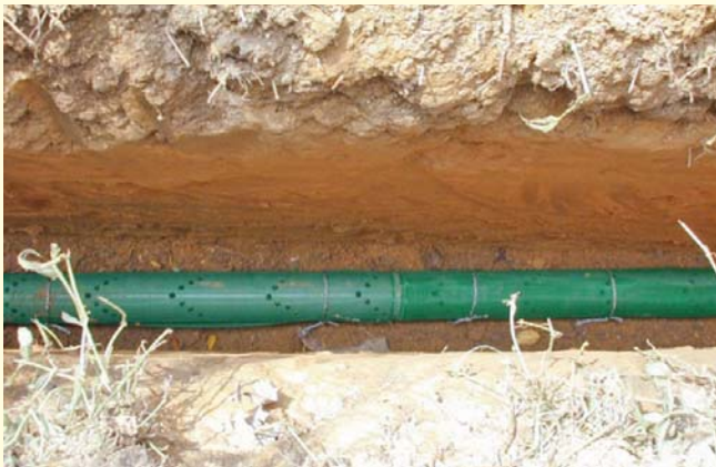
圖十六、果園土壤因之前種植水稻和質地不均致排水不良（土壤灰斑明顯），可埋入已挖孔和包裹紗網之塑膠管，然後填上一層級配，再覆上耕作土。
