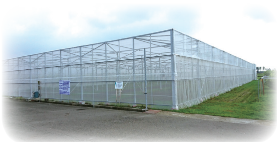
圖 17. 本場所搭建之直立柱型水平網室 (由旺田溫室設備公司承造)
