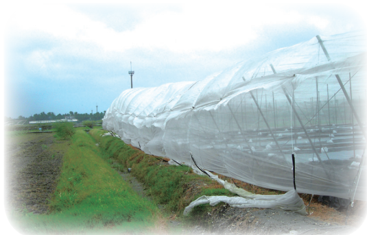
圖 13. 防蟲網因強風吹襲而大幅波動，為造成破網主因。
