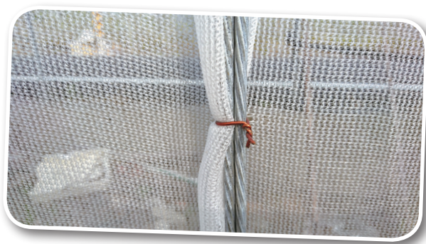
圖 14. 塑膠網網紮固定於鋼索的方式
