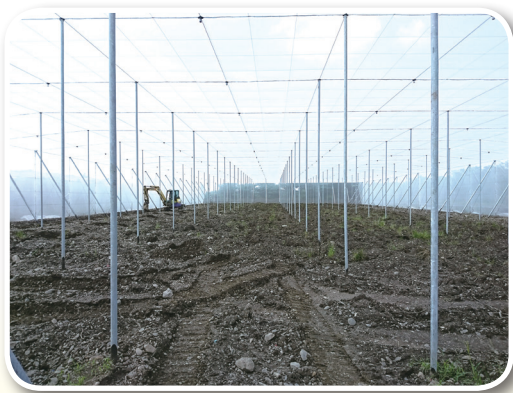
圖 7. 網室上方鋼索線經緯相交處均需固定
