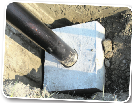
圖 3. 斜柱下方放置水泥板避免立柱下陷
