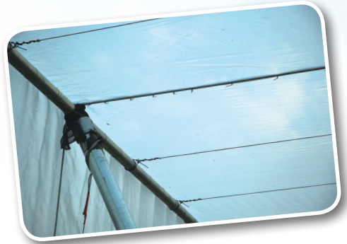
圖 4. 網室周邊上方橫樑的搭建方式
