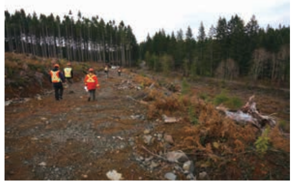
▲ 採伐後便道碎石鋪面移除至下一作業區，同時保留排水系統。
