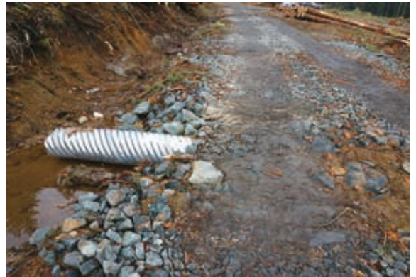
▲ 伐區內施工便道，依作業道路規範於路面鋪碎石、設側邊溝並埋設橫向水管，促進伐區排水。
