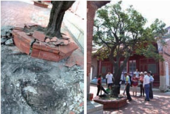
▲ 圖6、7、兩棵位於文武廟中的象牙木根系使花台破損及瓷磚開裂。
