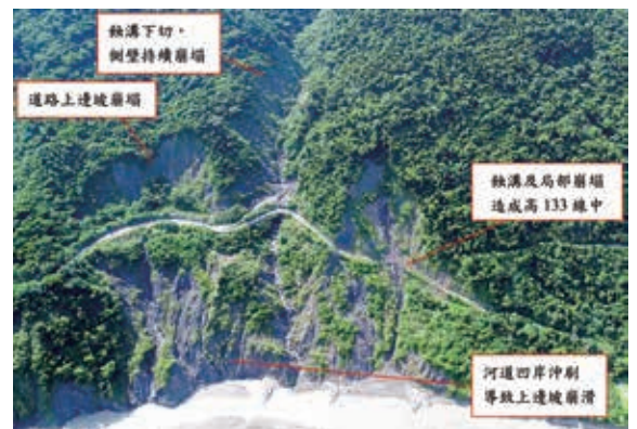
▲圖1、六龜區-D015高133線道路邊坡局部崩塌（林務局，105年）
