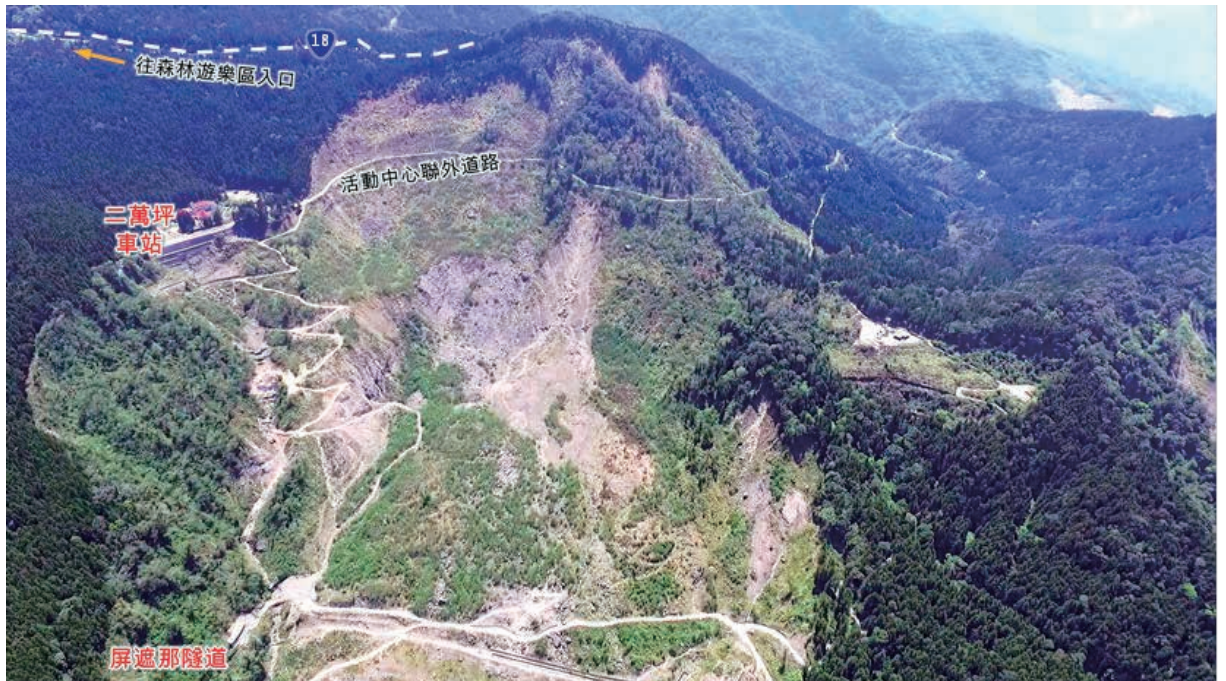
▲圖2、二萬坪崩塌地空拍現況（拍攝日期：105年5月）
