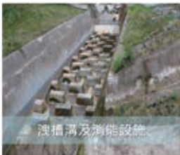
乾砌石駁坎及固床工
