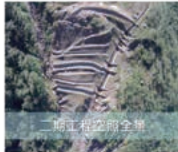
乾砌石駁坎及固床工
