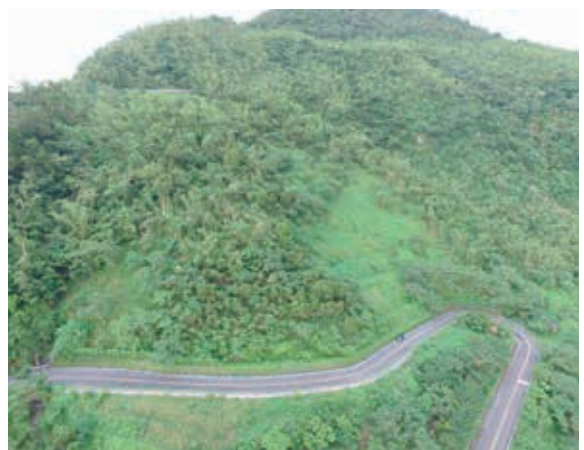
▲圖17、藤枝2K大規模崩塌地整治後現況
