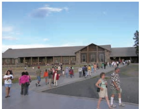
▲黃石國家公園之遊客服務中心使用木材及石材為建材，外觀色彩能與大自然協調；圖中遊客行走的灰色步道係以回收塑膠瓶所製成的綠建材，配合告示牌解說，達到環境教育的功能。
