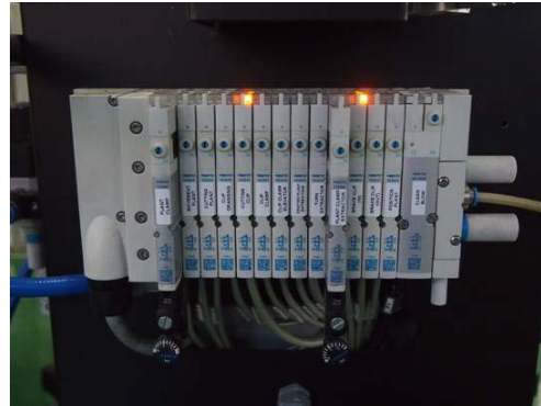
圖十一、電磁閥組 Fig. 11. Solenoid valve group
