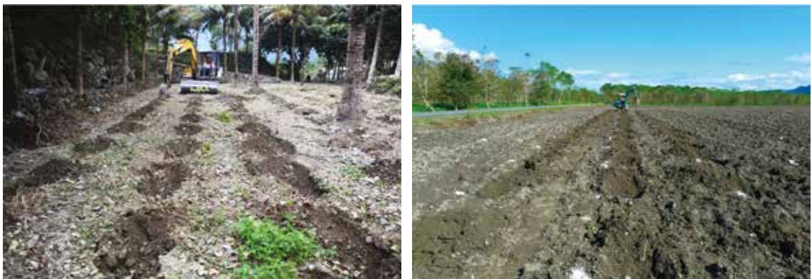
圖1 淺山造林之怪手整地與植穴挖掘：臺東太麻里嘉蘭試區(左)；花蓮光復試區(右) (陳永修 攝)
