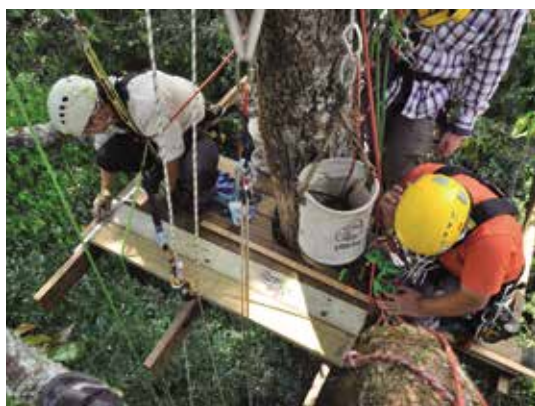
樹冠平臺施工(傅國銘 攝)
