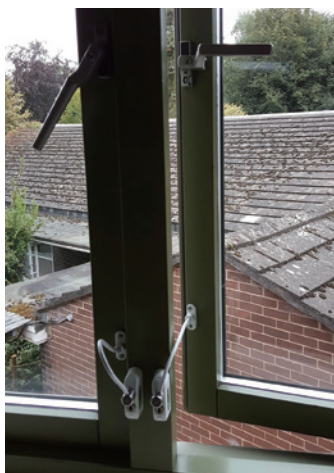
圖7、窗戶可以密閉隔絕熱逸散是建築改善的主要途徑之一。
