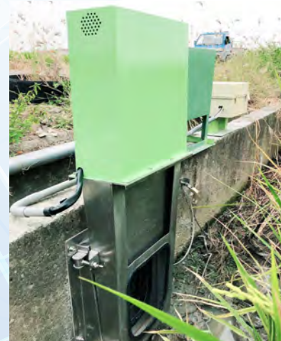
▲ 水田監控管理系統垂直升降式電動水閘門，與水田傳感器與田間挈動器整合，進行田間自動灌溉（國立中興大學提供）
