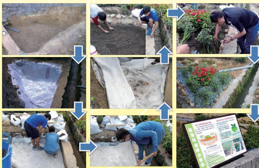
圖三、植生滯留槽施工流程
