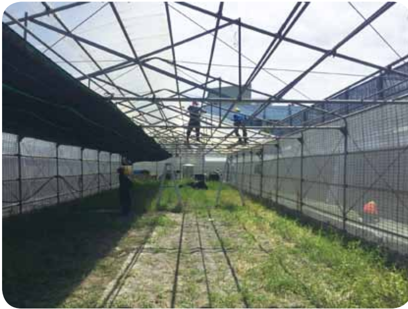
圖 4. 105 年尼伯特颱風後，拆除原有破碎塑膠浪板，覆蓋 70% 遮光明瞭臺東地區栽培香菸蘭百吉網。
