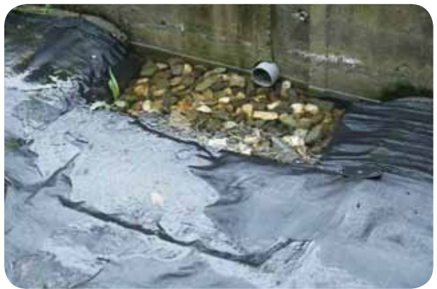
圖 5. 豪雨來襲時，排水管路發揮效用，避免積水。
