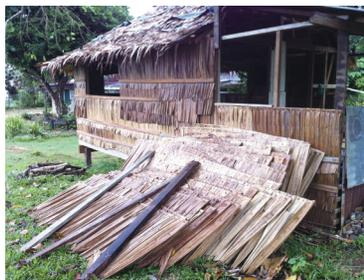
製作中的高腳屋，牆邊堆置著西穀椰葉片製成的牆面半成品。
