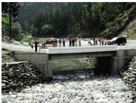
圖4 扇平溪一號橋復建後情況(2011.2.17)(黃瓊璐攝)
