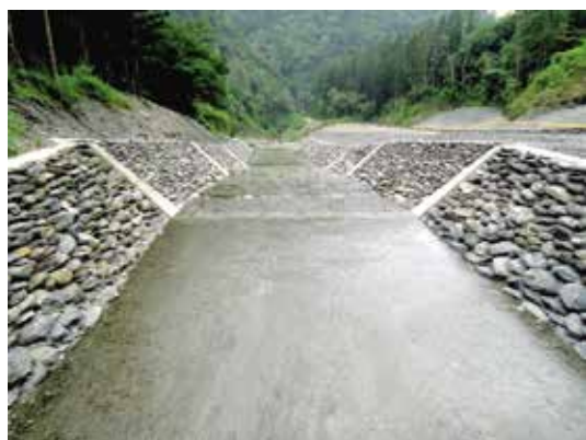
圖7 扇平溪一號橋下游復建完工狀況(2011.12.1)(黃瓊璐攝)
