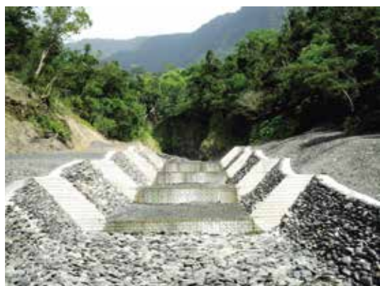
圖8 扇平溪一號橋上游復建完工狀況(2011.2.17)(黃瓊璐攝)
