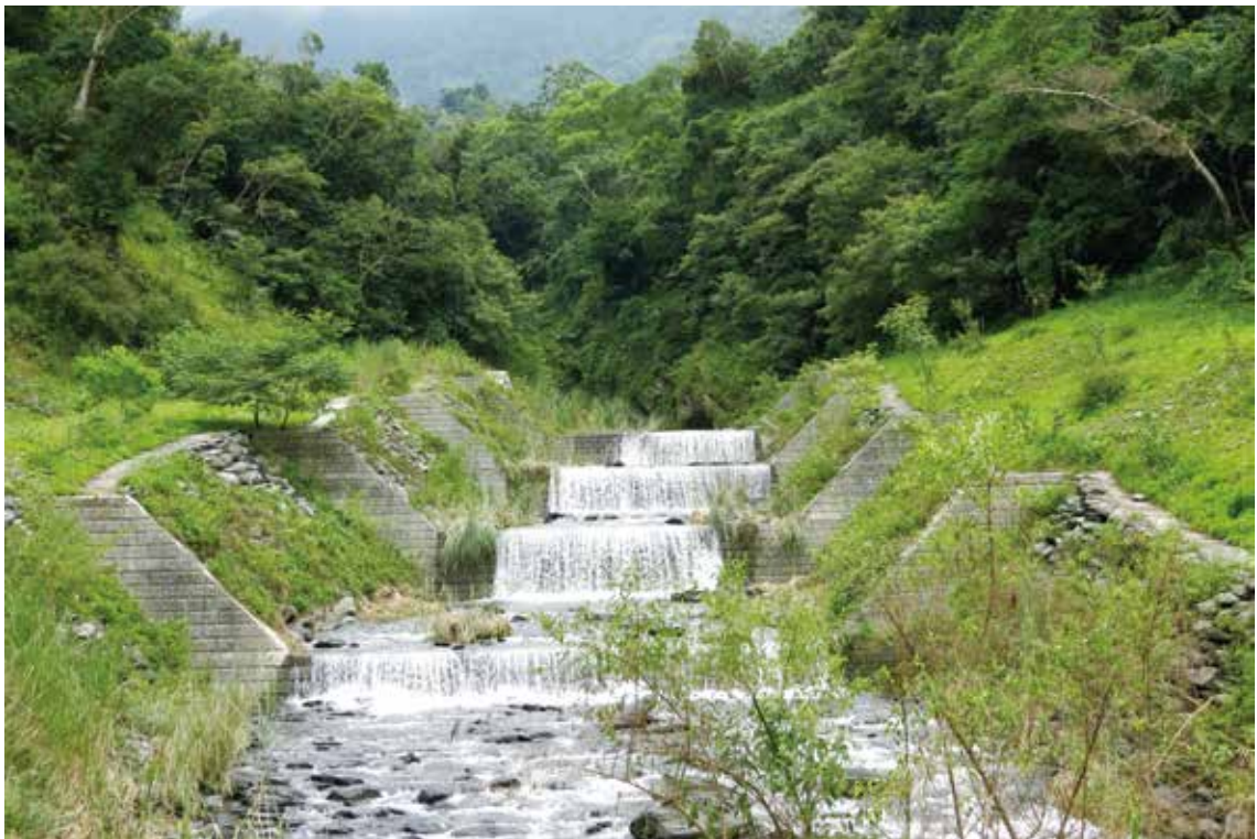
圖10 扇平溪一號橋上游植生回復狀況(2014.7.30)(黃瓊璵攝)
