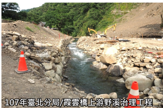
半半施工、 維持常流水
