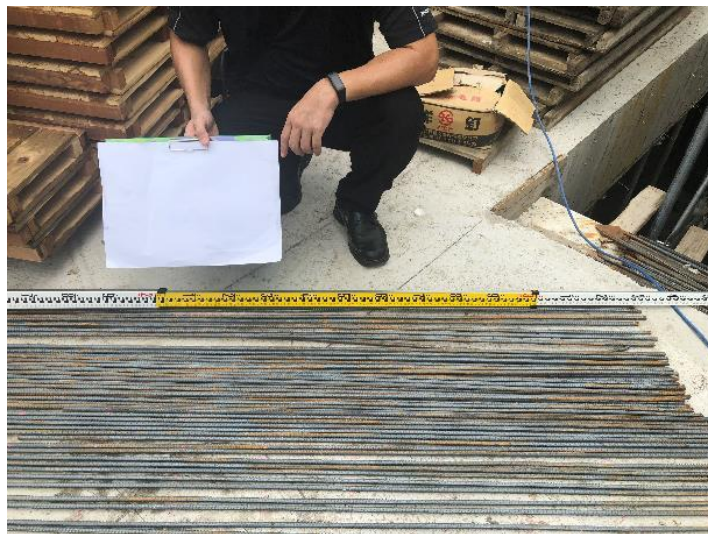
圖 2-3-4 尺度攝影連續性錯誤樣態(沒有拍到起點)
