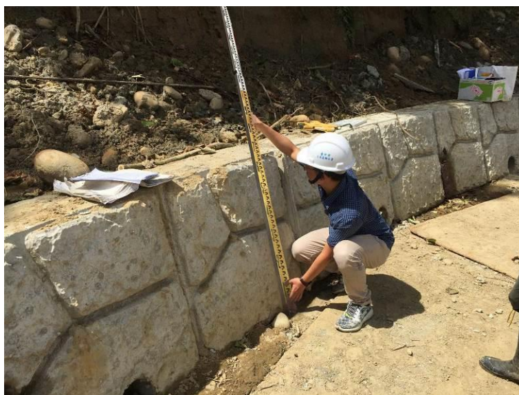
圖 2-3-3 尺度攝影正確樣態(刻度清晰)
