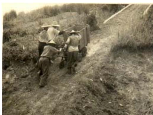
圖 2. 民國 61 年引進三輪式動力搬運車在爬坡試驗場 40% 陡坡進行試驗情形。
