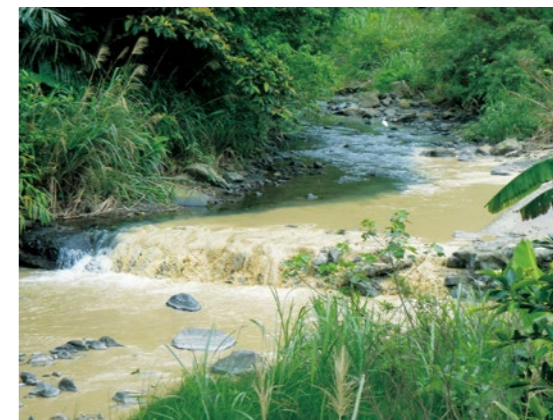
上游施工造成的溪水混濁，影響溪流生態系及其服務。
