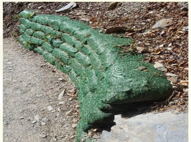
圖七、礫石網袋的擋土牆。
