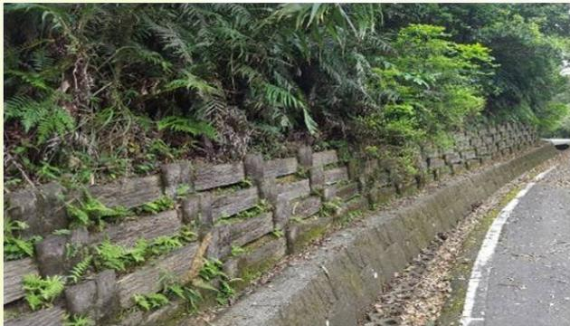
圖六、臺北汐止產業道路旁層架構築植物覆面擋土牆。
