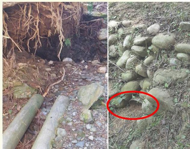
圖十四、平台旁設置簡易木樁明渠與石牆下涵（暗）管埋設。
